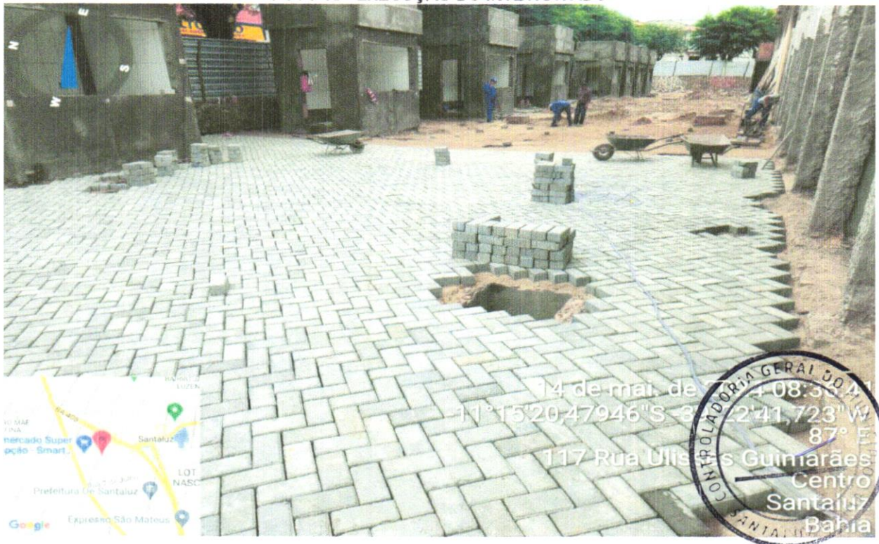
FOTO 36- EXECUÇÃO DO INTETRAVADO
