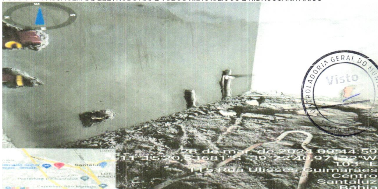
FOTO 04 – PASSAGEM DE ELETRODUTOS E TUBOS HIDRÁULICOS E HIDROSSANITÁRIOS
