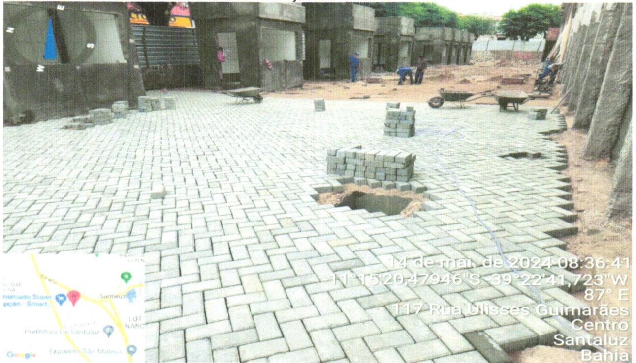
FOTO 38- EXECUÇÃO DO INTETRAVADO
