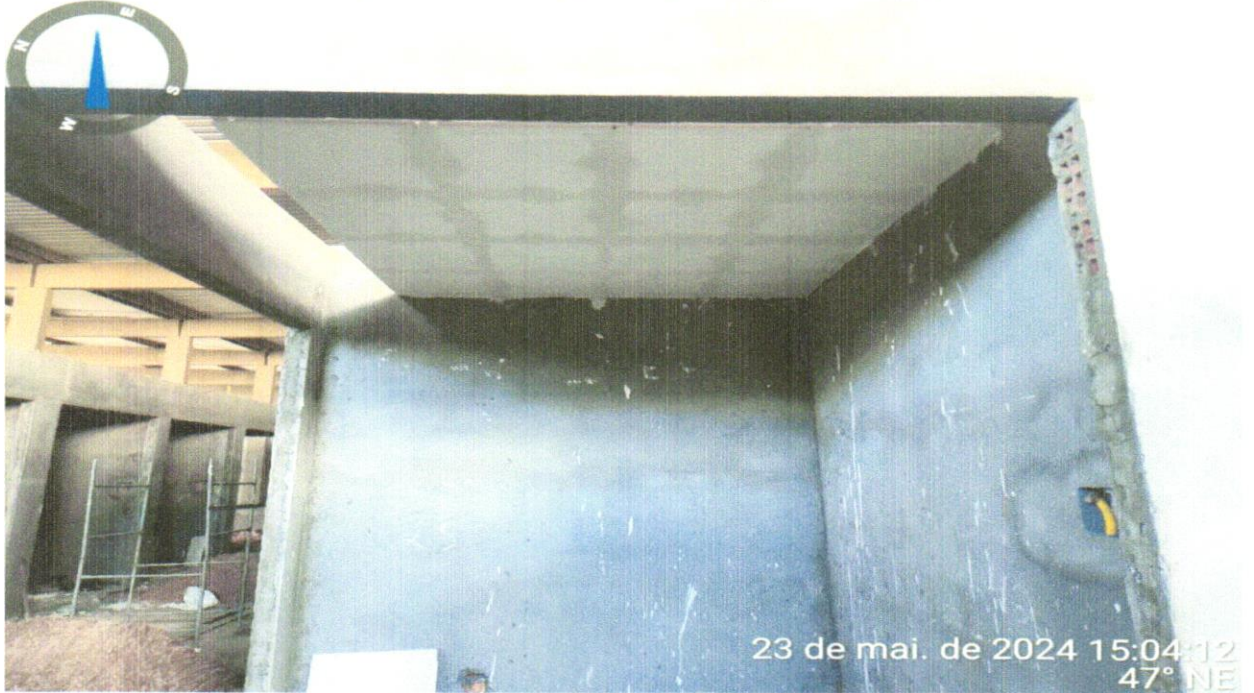
FOTO 44- FORNECIMENTO E INSTALAÇÃO DO GESSO
