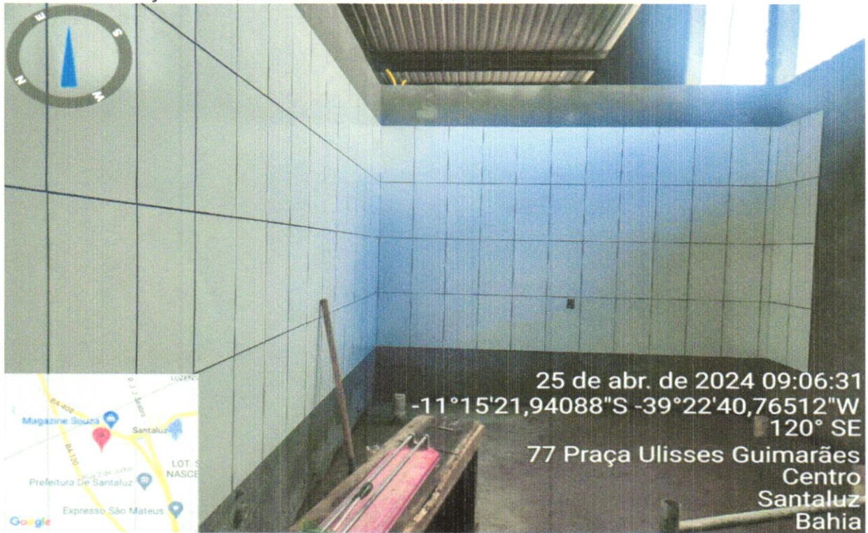
FOTO 30 – EXECUÇÃO DO REVESTIMENTO DOS BANHEIROS
