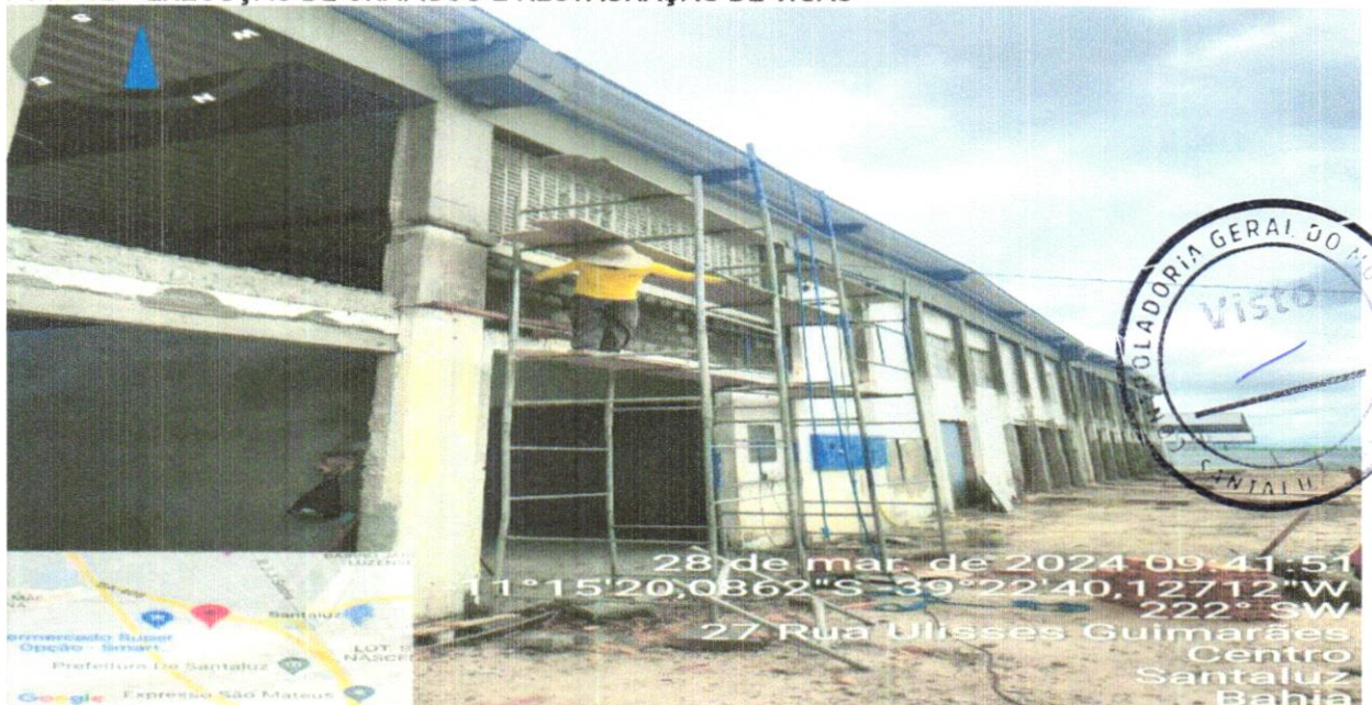
FOTO 02 - EXECUÇÃO DE CHAPISCO E RESTAURAÇÃO DE VIGAS
