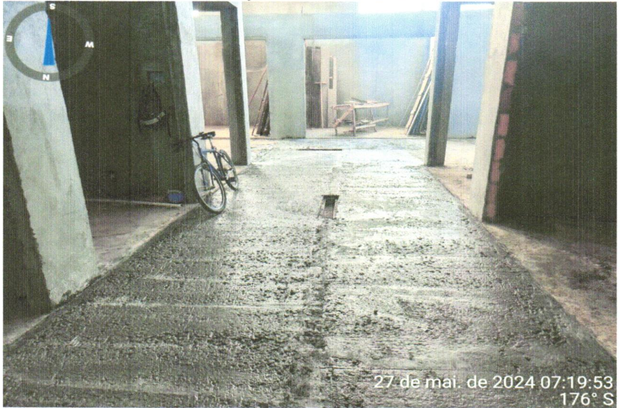
FOTO 42- EXECUÇÃO DO CONCRETO PARA POLIMENTO
