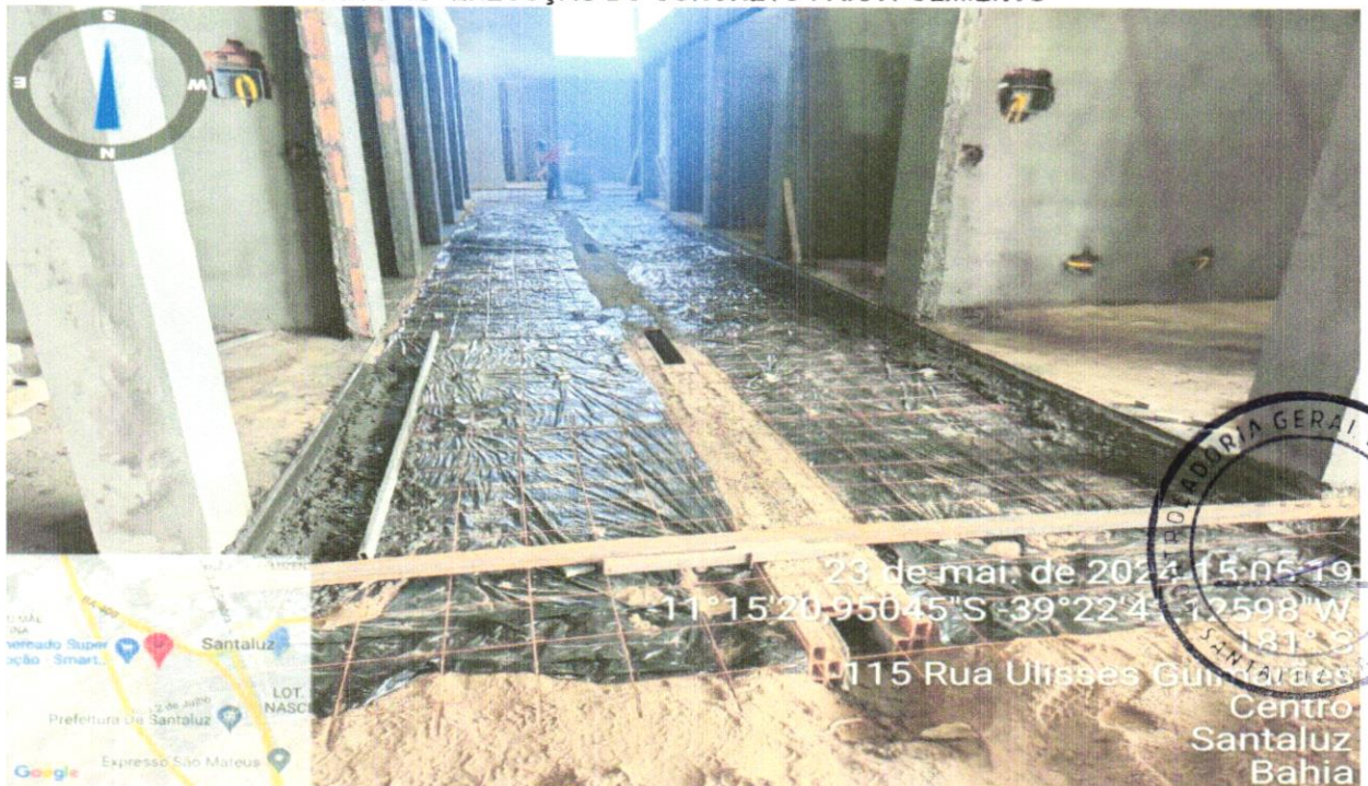
FOTO 42- EXECUÇÃO DO CONCRETO PARA POLIMENTO
