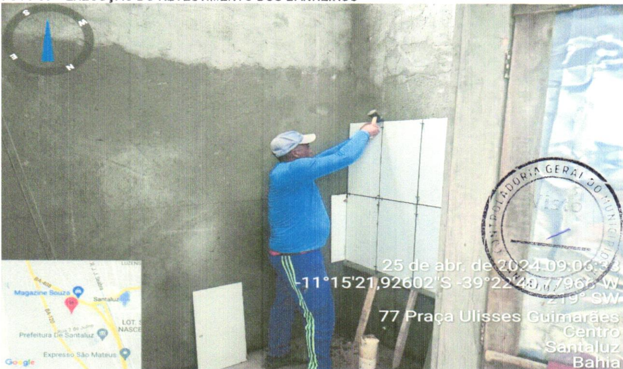
FOTO 30 – EXECUÇÃO DO REVESTIMENTO DOS BANHEIROS
