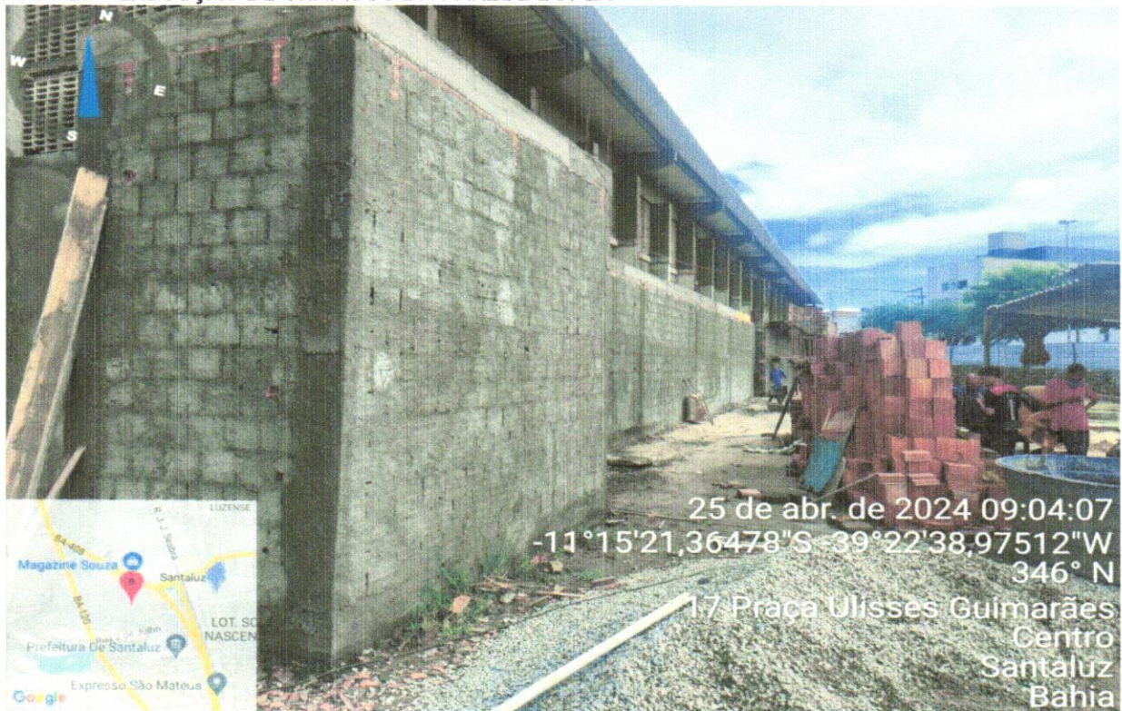
FOTO 28 – EXECUÇÃO DE RESTAURAÇÃO DOS PILARES
