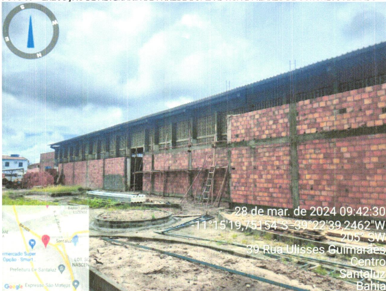
FOTO 04 – PASSAGEM DE ELETRODUTOS E TUBOS HIDRÁULICOS E HIDROSSANITÁRIOS
