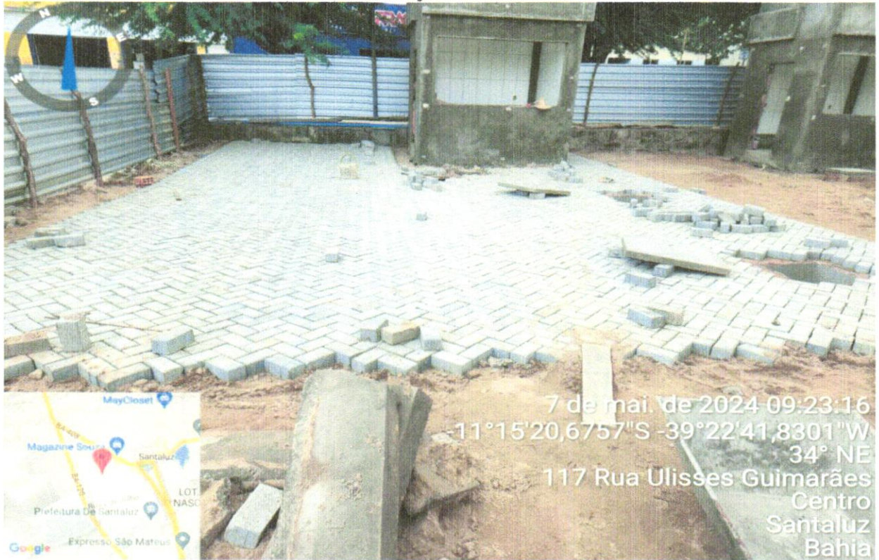
FOTO 36- EXECUÇÃO DO INTETRAVADO
