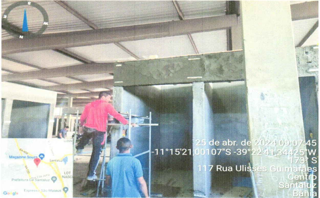
FOTO 24 – EXECUÇÃO DE REBOCO
