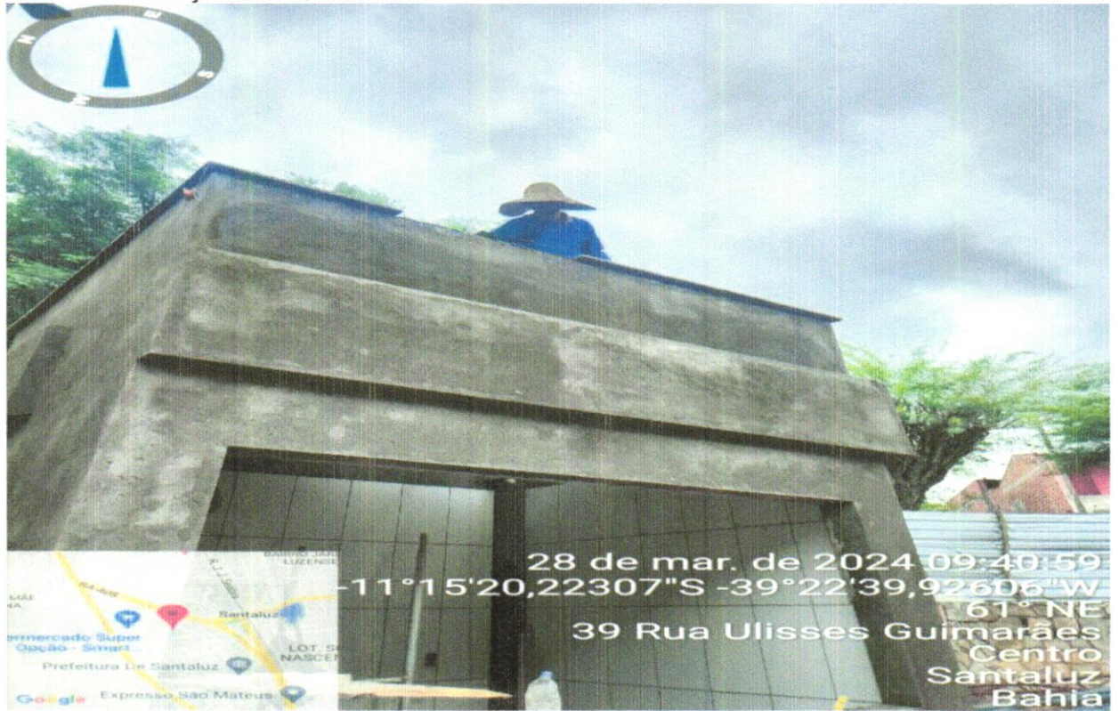
FOTO 16 -EXECUÇÃO DE CAIXA DE GORDURA
