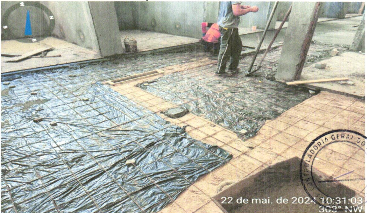
FOTO 40- EXECUÇÃO DO CONCRETO PARA POLIMENTO
