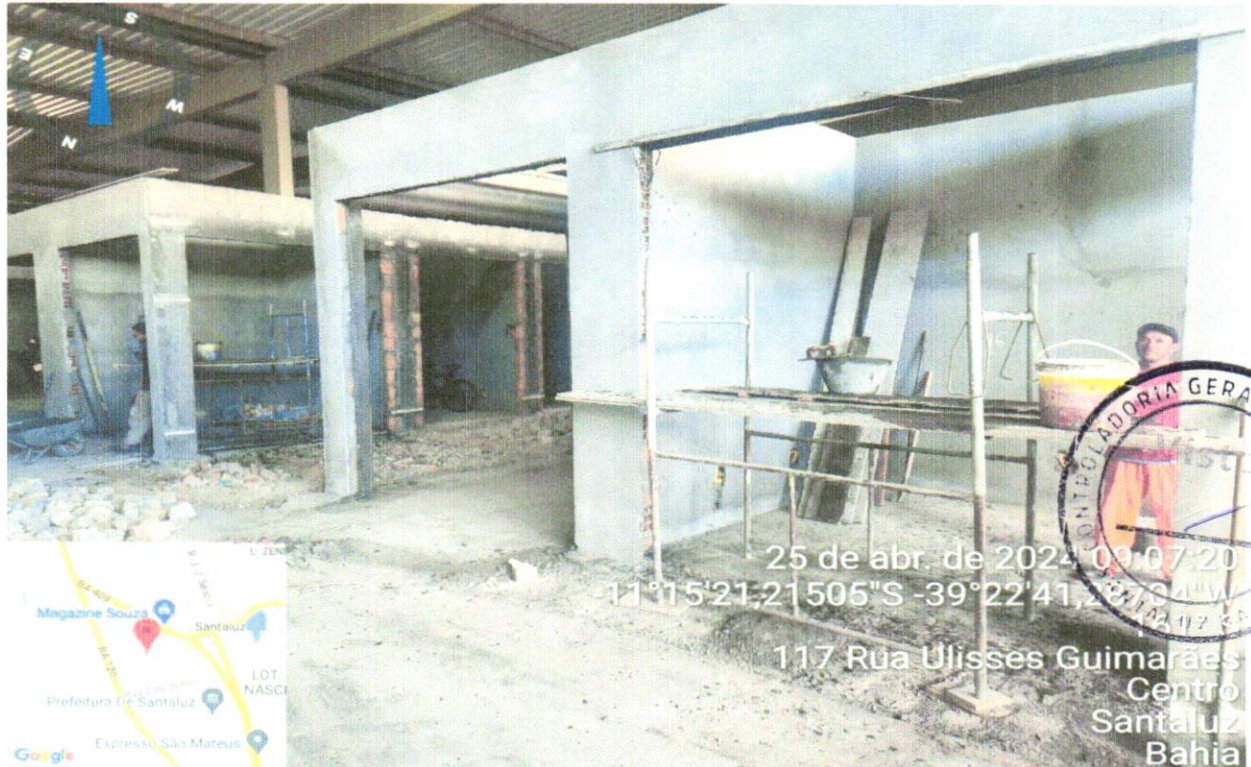
FOTO 22 – ACABAMENTO DO REBOCO DAS PORTAS
