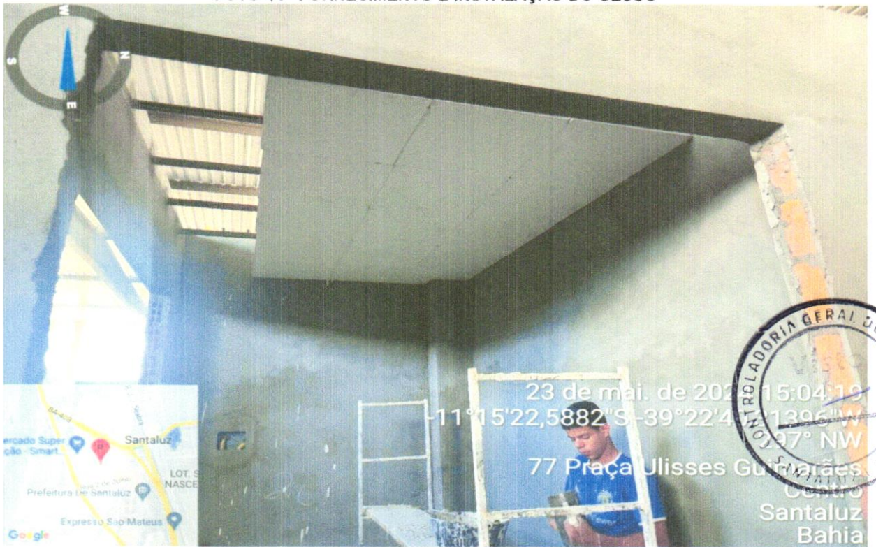
FOTO 44- FORNECIMENTO E INSTALAÇÃO DO GESSO
