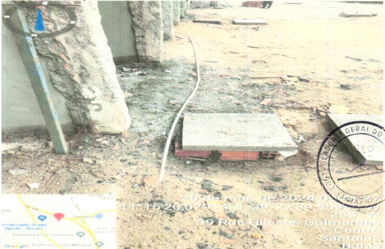
FOTO 10 – RESTAURAÇÃO DOS PILARES E EXECUÇÃO DAS CAIXAS DE PASSAGEM
