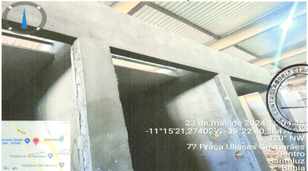
FOTO 46- FORNECIMENTO E INSTALAÇÃO DO GESSO
