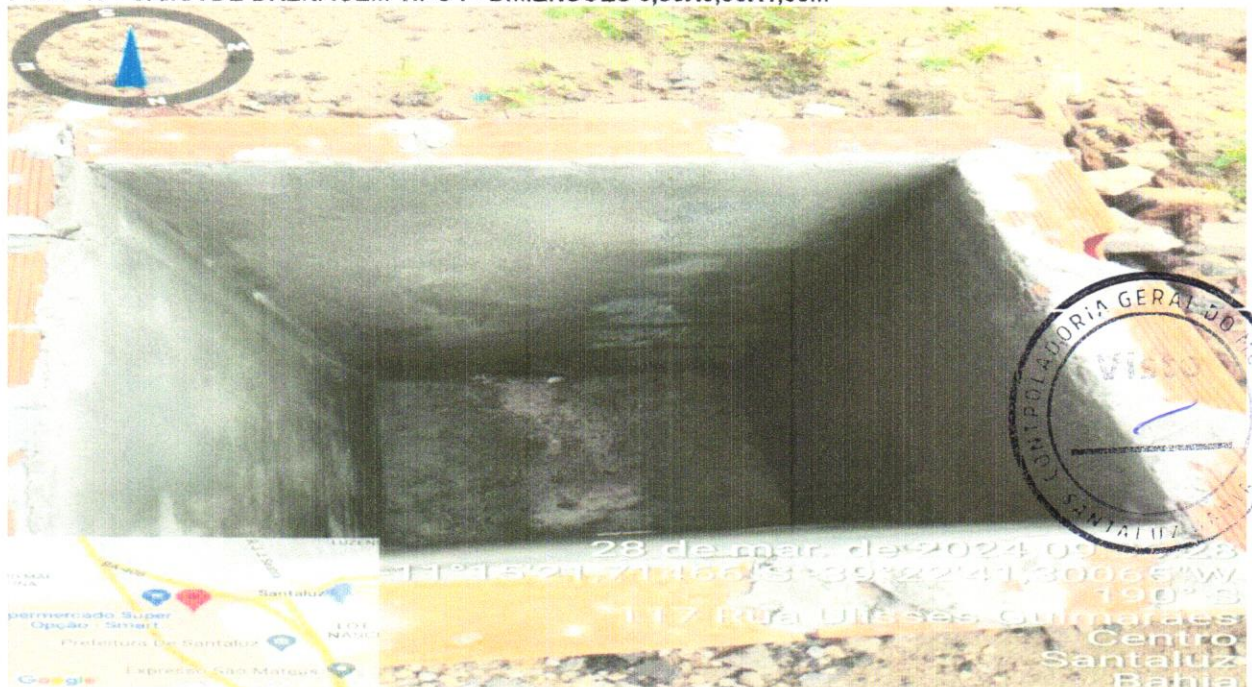
FOTO 18 - CAIXA DE DRENAGEM TIPO I - DIMENSÕES 0,80X0,80X1,00M
