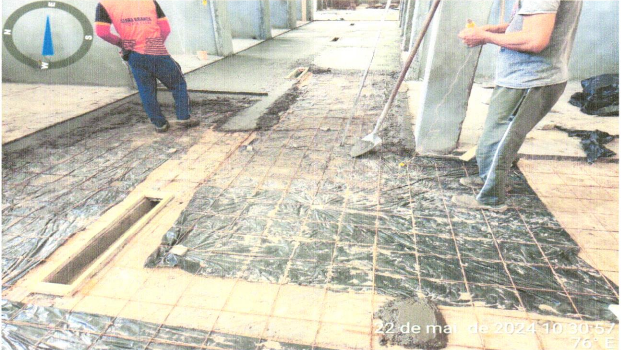
FOTO 40- EXECUÇÃO DO CONCRETO PARA POLIMENTO
